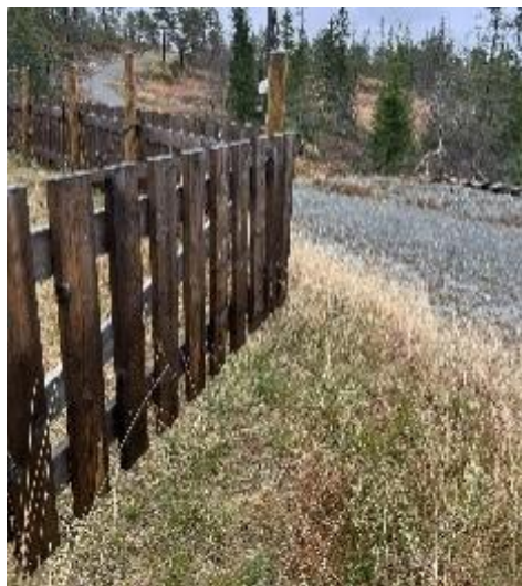
Bilde 3. Enkelt stakittgjerde
